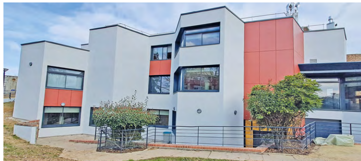
La médiathèque des 7 Mares, la 1 re du réseau des médiathèques de SQY, a ouvert le 29 décembre 1975. Elle a fait l'objet d'une rénovation en 2022-2023 (ici peu de temps après sa réouverture).
