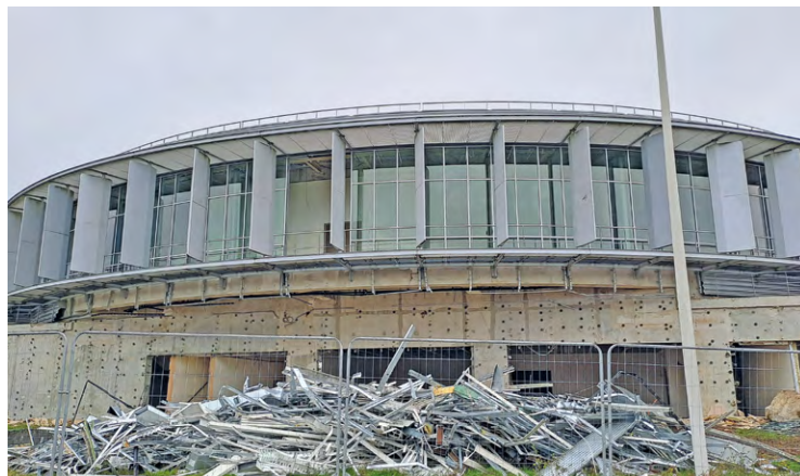
La bâtiment, vieux de 20 ans, était inoccupé et faute de repreneur, « nous avons décidé de le démolir car son entretien représente un coût non négligeable pour l'entreprise », justifie Renault.
