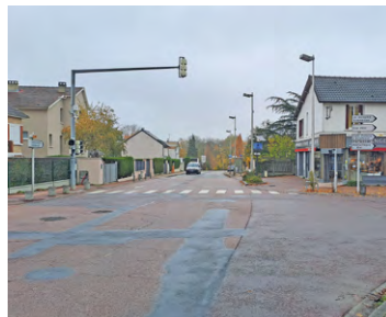
« Pendant toute la durée des travaux, des alternats et itinéraires de déviation seront mis en place par une signalétique dédiée », précise la Ville.
