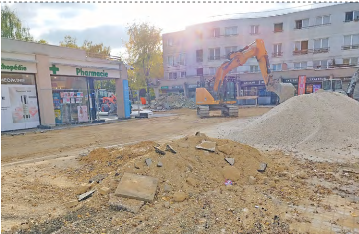
Les travaux de la place Nelson Mandela, aux Clayes, ont commencé le 6 octobre. Ils sont censés durer 4 mois.
