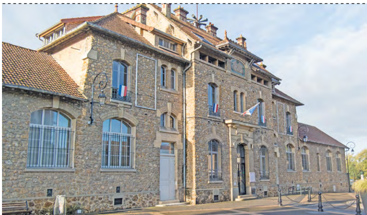
Isolation thermique, toiture, équipements de chauffage ou d'eau chaude, ventilation, ou encore changement de fenêtres, font partie des interventions éligibles.
