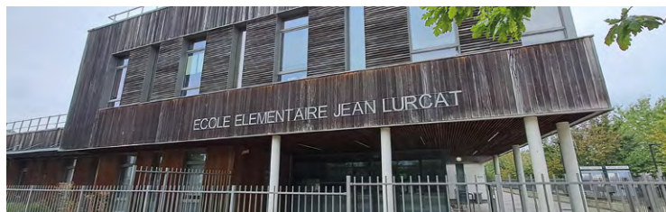
À Guyancourt la Ville a demandé 8 120 euros pour remplacer le jeu en 3 D, cassé, situé dans la cour de l'école élémentaire Lurcat.
