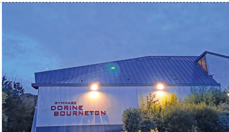
Au gymnase Bourneton « une nouvelle armoire électrique va être posée pour le plateau d'évolution », fait savoir la municipalité.
