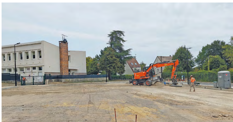
L'entreprise Colas est chargée de réaliser ce chantier. Il devrait normalement se terminer avant la fin de cet été.
