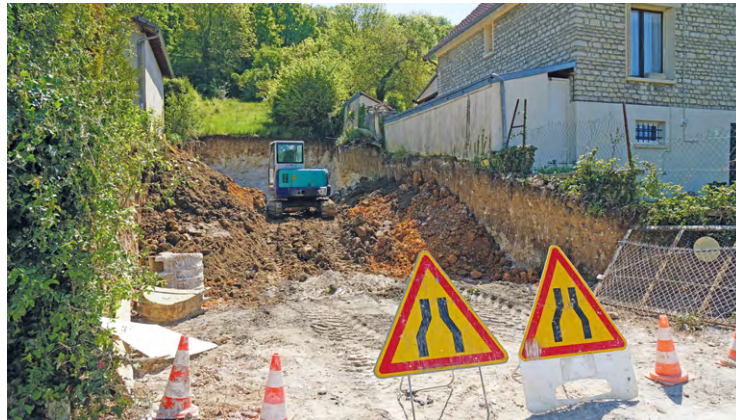
L'un des voisins, Christophe, avait fait venir un huissier pour empêcher le début du chantier.
