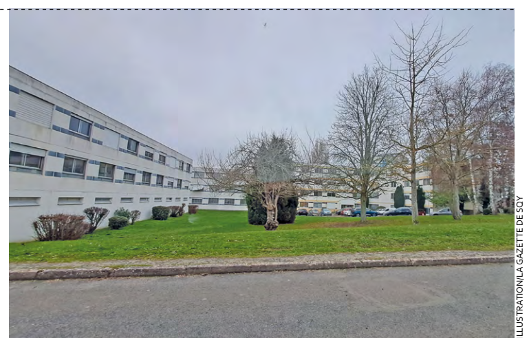
L'arrêt du chantier de l'hôpital psychiatrique de Plaisir a coûté un million d'euros, au bénéfice de Dumez Île-de-France, filiale de Vinci construction.
