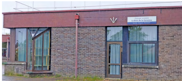
Le projet retenu pour le devenir du site du Bois de la Garenne est celui proposé par Nexity, baptisé Voisinage.
