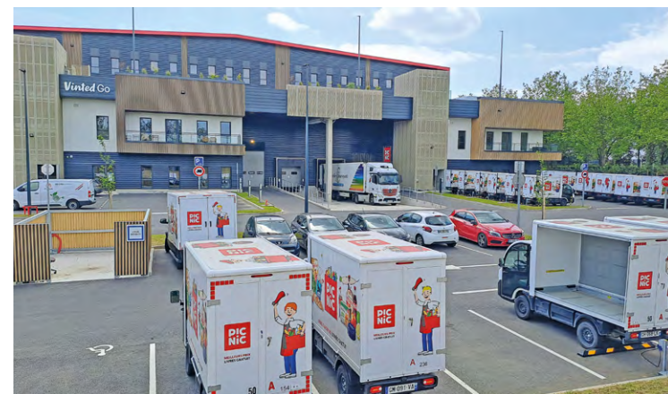
Quatre entreprises sont déjà installées au sein du Segro Park Élancourt, dont Vinted Go (plateforme de vente de vêtements de seconde main en ligne), et Picnic (supermarché en ligne).
