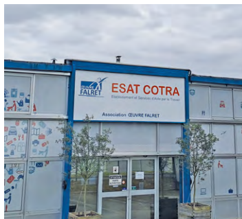
L'Esat Cotra est situé en entrée de ville à Fontenay-le-Fleury mais devra déménager ses activités en raison du projet Fossé Pâté consistant en l'aménagement d'un nouveau quartier.
