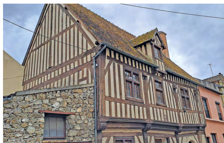
La Maison Saint-Vincent (photo) verra sa toiture rénovée pour « un peu moins de 100 000 euros », tandis que l'église bénéficiera d'une reprise de sa charpente et ses menuiseries, selon le maire.
