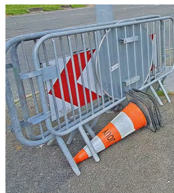
Une circulation alternée a été mise en place et elle devrait durer une bonne partie des travaux.
