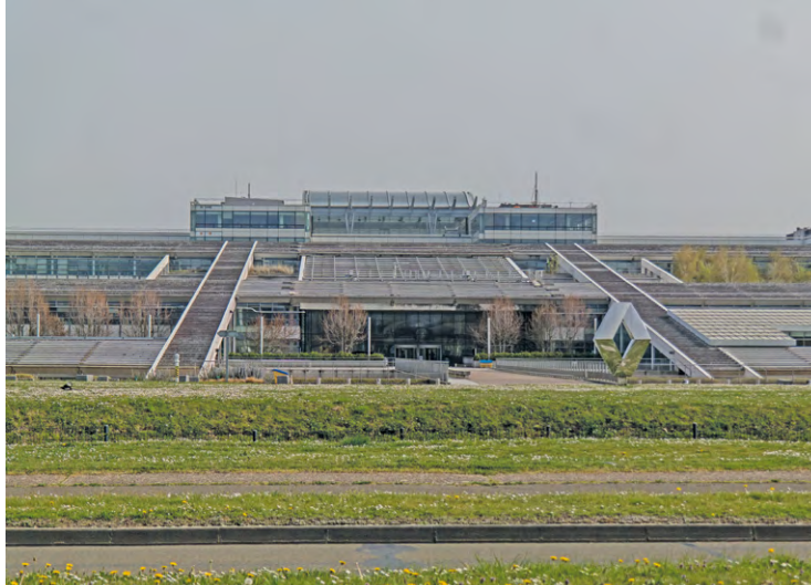
Les terrains du Technocentre de Renault, situé à l'est de la RD 91, auront un avenir tout autre. Les emprises de travaux de construction de la ligne 18 du Grand Paris Express s'y installeront.
