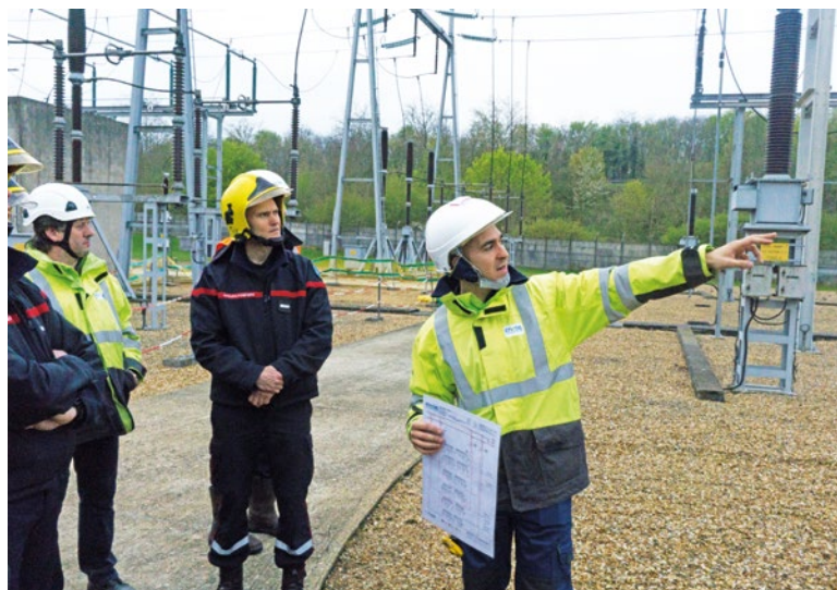
Les sapeurs-pompiers de Magny-les-Hameaux ont été briefés par des représentants d'Enedis sur le fonctionnement des installations électriques haute tension et les risques qui y sont liés.
