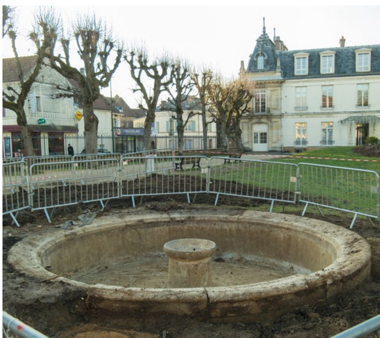
La fontaine, de style contemporain, comporte une vasque en béton de 3 m de diamètre environ.
