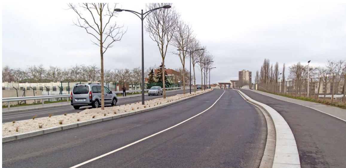
Le doublement du pont Schuler est notamment le premier tronçon, sur six au total, d'une voie dédiée aux bus qui reliera à terme Trappes à La Verrière.
