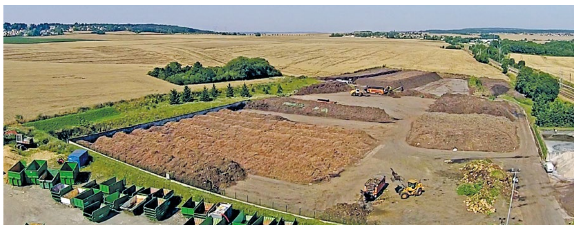
Plateforme de déchets verts
