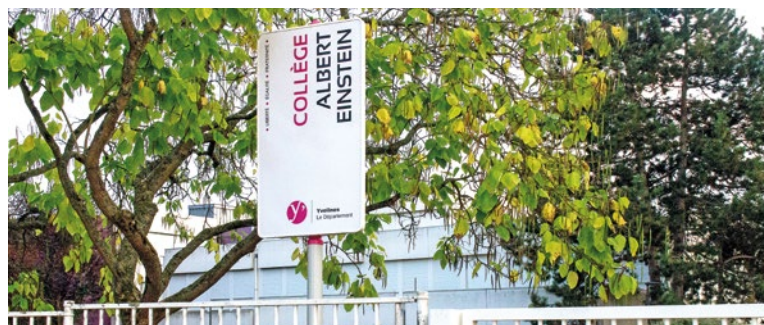
Plusieurs dysfonctionnements ont été identifiés par le Département au collège Einstein : déficit de salles, absence de préau, locaux enseignants sous-dimensionnés, abri vélo en mauvais état.
