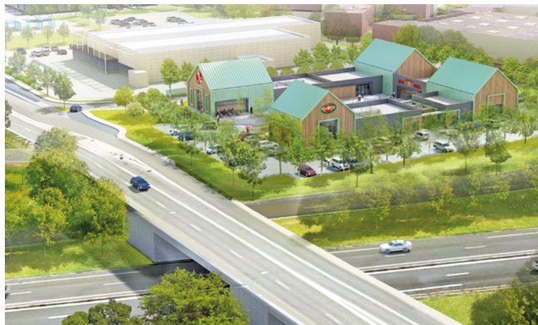
Les travaux du Village des restaurants ont débuté en juillet dernier dans le secteur du Pas du lac. D'après Habitat et commerce, l'accès devrait se faire directement par la route départementale.
