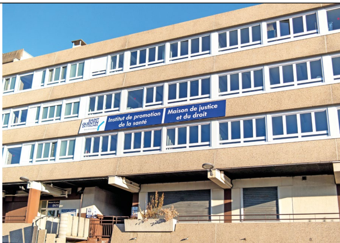
En attendant de trouver des locaux pour installer son hôpital de jour, le Centre hospitalier de Plaisir a malgré tout commencé l'activité, au sein de l'Institut de promotion de la santé (IPS).
